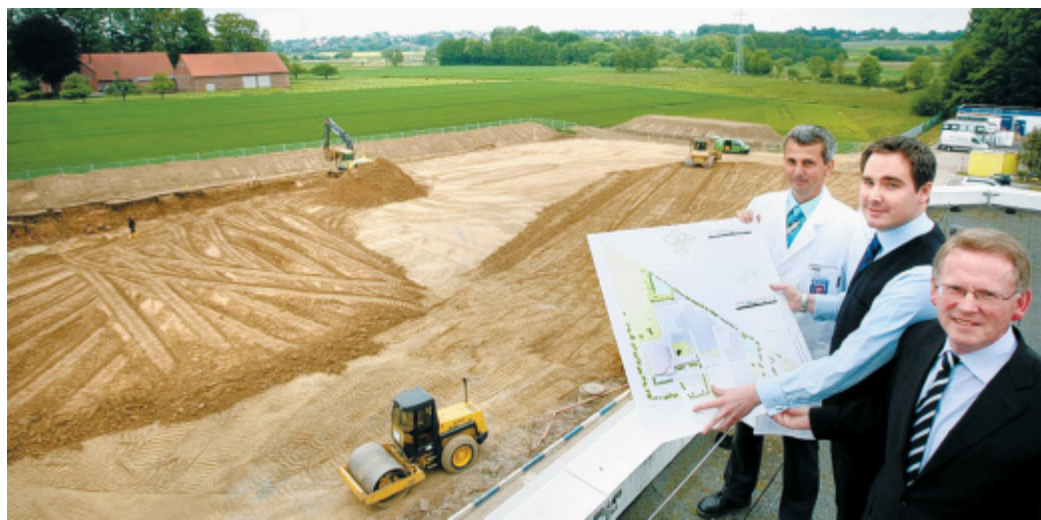
Die Bagger sind da: Auf dem Dach des Bürotrakts über der Baustelle zeigen (v. l. Produktionsleiter Jens Rautengarten, Geschäftsführer Frank Sieverding, Franz-Josef Schewe) die Grundrisspläne. FOTO: KIEL-STEINKAMP
